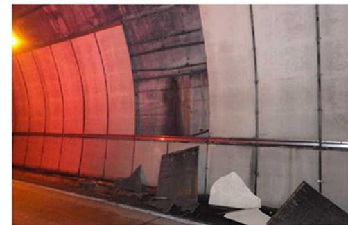
写真-3 パネル浮かし張りの落下事例<sup>3)</sup>
