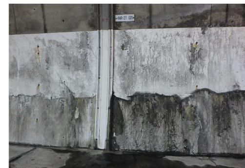
写真-4 内装塗装の変状事例
