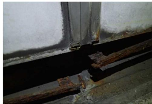
写真-2 パネル浮かし張り（金具）の変状事例
