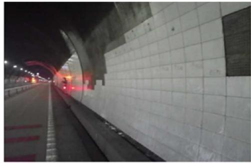
写真-1 タイル直張りの変状事例<sup>4)</sup>
