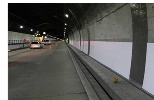
写真-5 塗装材を用いた内装工の施工事例
